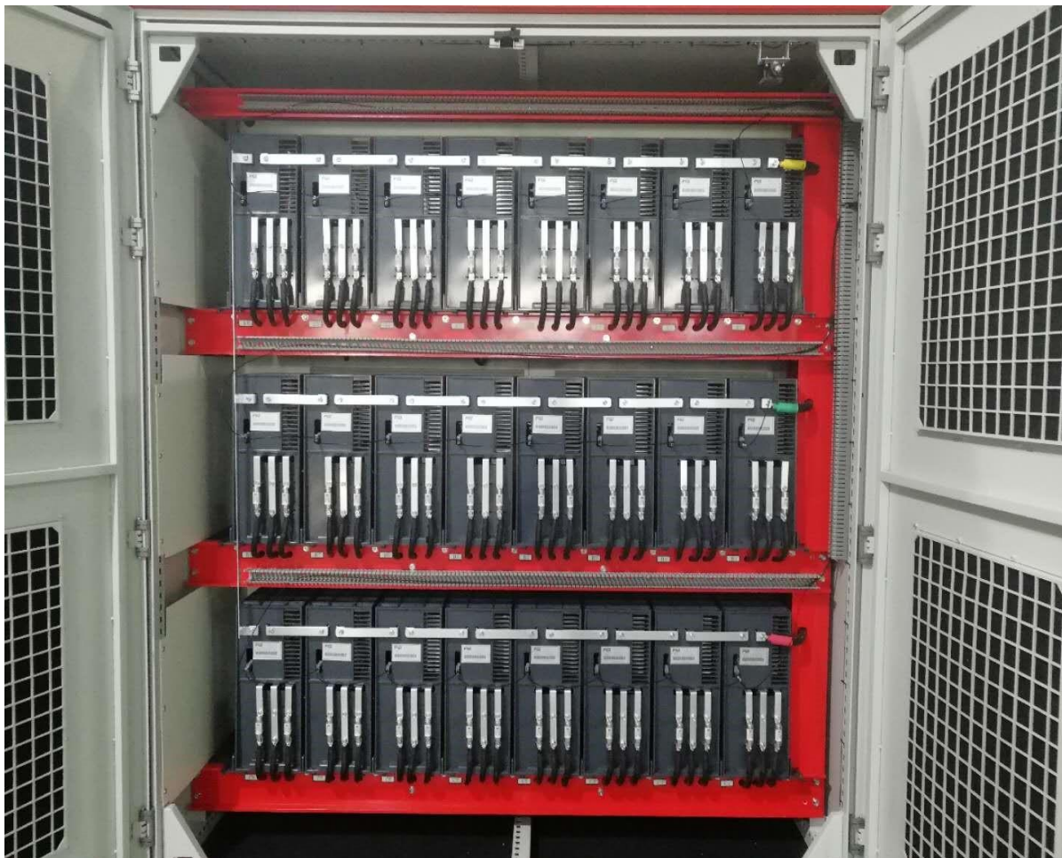
Рисунок 2.6. Внешний вид шкафа инвертора с открытой дверью
